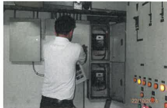
รูปที่ 10 มิเตอร์ไฟฟ้าสำหรับระบบบำบัดน้ำเสียของโครงการ โดยเฉพาะแยกจากระบบไฟฟ้าอื่นๆ
