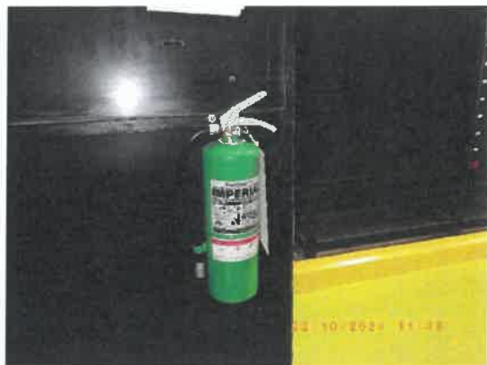
รูปที่ 33 (ต่อ) ถังดับเพลิงเคมี ชนิด ABC ขนาด 10 ปอนด์
