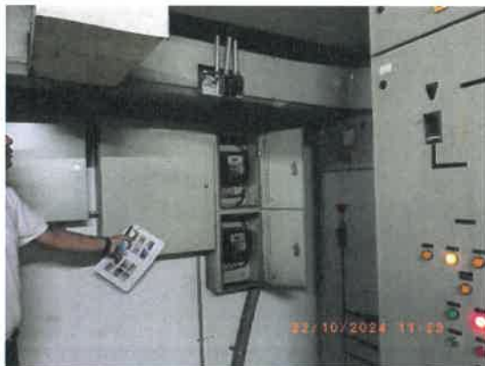
รูปที่ 10 มิเตอร์ไฟฟ้าสำหรับระบบบำบัดน้ำเสียของโครงการ โดยเฉพาะแยกจากระบบไฟฟ้าอื่นๆ
