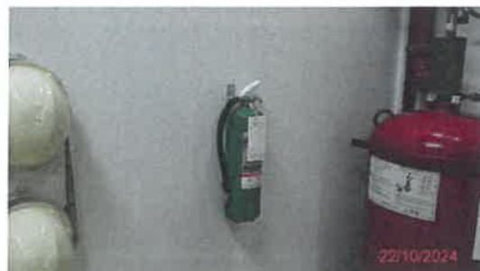
รูปที่ 33 (ต่อ) ถังดับเพลิงเคมี ชนิด ABC ขนาด 10 ปอนด์
