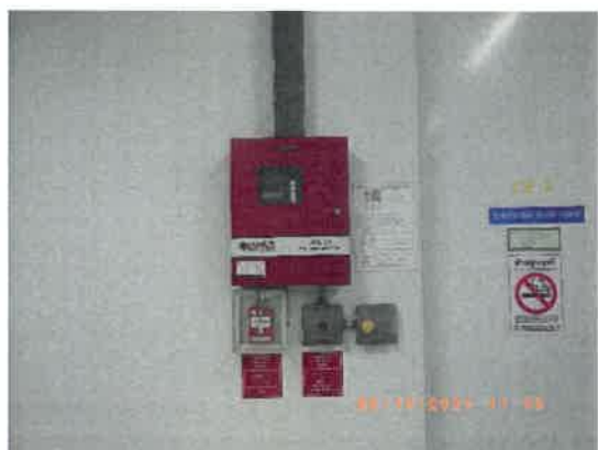
รูปที่ 38 ระบบเตือนภัย Fire Alarm Control Panal : FCP
