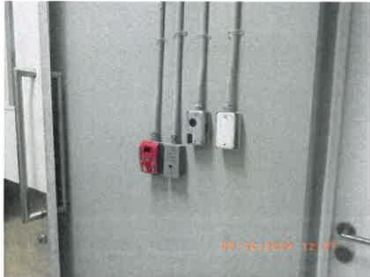
รูปที่ 41 เครื่องแจ้งเหตุโดยใช่มือดึง (Fire Alarm Manual Station)
