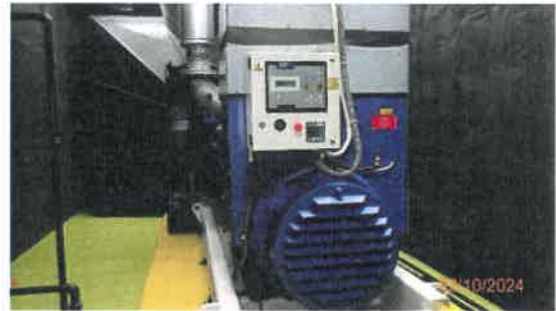
รูปที่ 26 ระบบไฟฟ้าสำรอง
