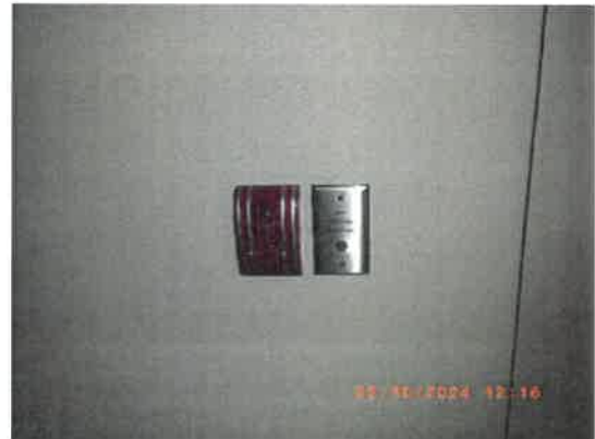
รูปที่ 41 เครื่องแจ้งเหตุโดยใช่มือดึง (Fire Alarm Manual Station)
